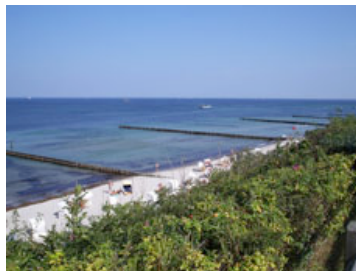
Pfähle im Ostsee bei Rostock (D)
