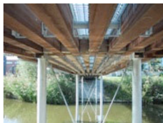
Brückenkonstruktion in Amsterdam (NL)
