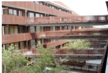
Fassadenverkleidung und Zaun von 150 Appartements, Utrecht (NL)
