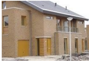
Fassadenverkleidung von hausen, Utrecht (NL)
