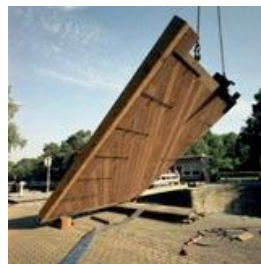
Schleusentoren in Tilburg (NL)
