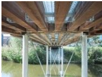
Brugconstructie in Amsterdam (NL)
