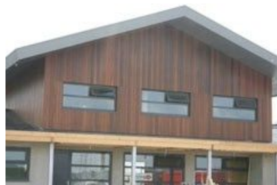
Fassadenverkleidung, Zuiderburen (NL)
