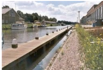
1. Jetty in Vianen (NL)
