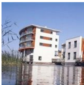
Terrassendielen bei Villen, Roosendaal (NL)
