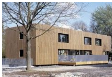
Fassadenverkleidung von Kinderkrippe, Uithoorn (NL)
