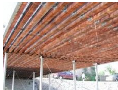
Brückenkonstruktion in Amsterdam (NL)
